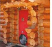
joint américain, utilisé lors du test d'étanchéité à l'air sur la maison de La Pessière. A gauche en bas, on aperçoit à la caméra thermique l'effet d'une fente dans un rondin. Le résultat du test du blowerdoor n'en sera cependant pas affecté. le système constructif est bien conforme à la RT2012.
