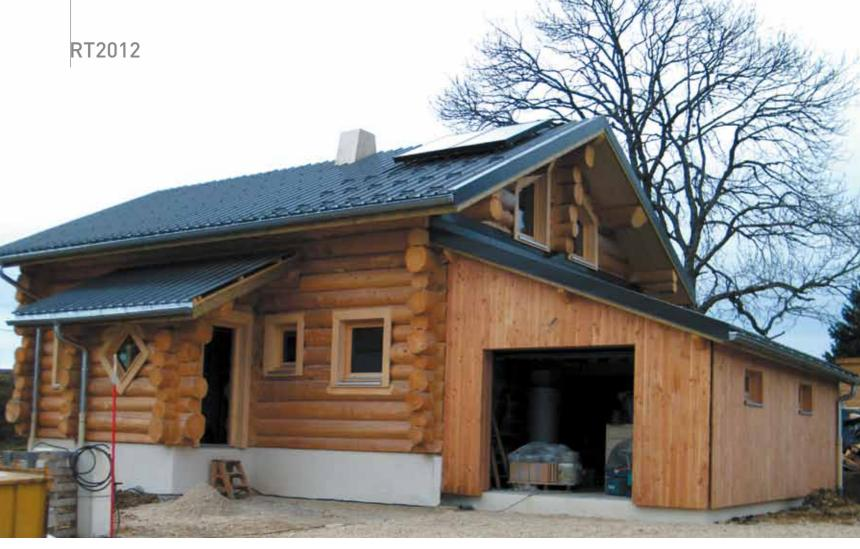
Pour le fustier : pas de révolution dans les pratiques, si ce n'est une plus grande attention dans les découpes, une étanchéité à l'air soignée à tous les niveaux, notamment avec un joint performant entre les rondins, mis en place sur la maison de La Pessière, en photo ici.
